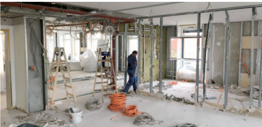
Blick auf die ITS-Baustelle im November 2019.
